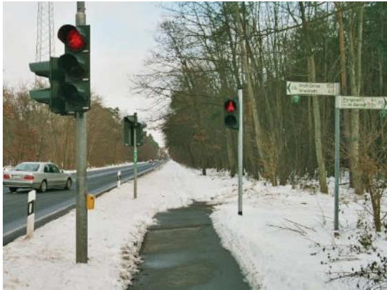
Abbildung 13: Ende eines geräumten Radwegeabschnitts an einer Gemarkungsgrenze (Kreis Groß-Gerau).
