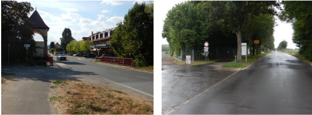
Abbildung 12: Ungeeigneter Übergang zwischen Fahrbahn und Radweg am Ortsausgang Offstein Richtung Heppenheim (links) und am Ortsausgang Eppelsheim Richtung Dintesheim (rechts).
