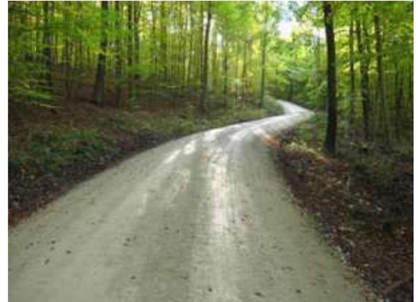
Abbildung: Beispiel gut befahrbare wassergebundene Decke
