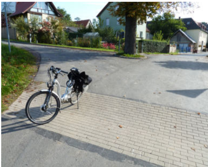
Großzügige Mulde als Entwässerungsrinne
