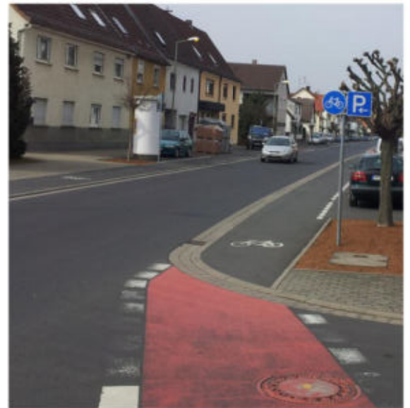
Abbildung 1: Bordsteinabsenkung Fahrbahn - Radweg, Frankfurt am Main
