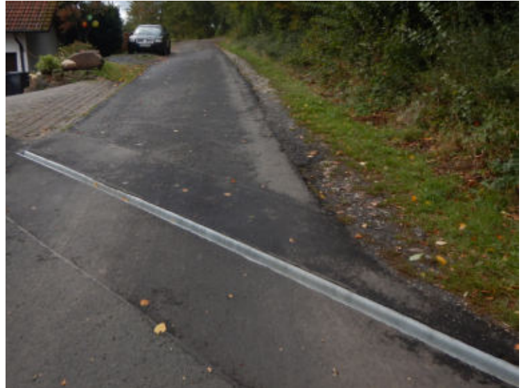
Entwässerungsrinne auf Wirtschaftsweg
