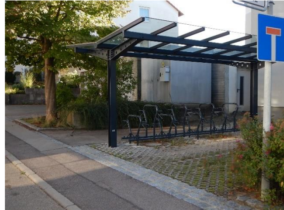
Abbildung 12: Überdachte Anlage des Typs „Beta HT“ am rückwärtigen Eingang des Seniorenzentrums
