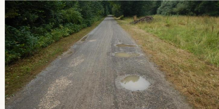
Negativbeispiel: verdichtete wassergebundene Decke mit Pfützenbildung und schlechter Wasserdurchlässigkeit
